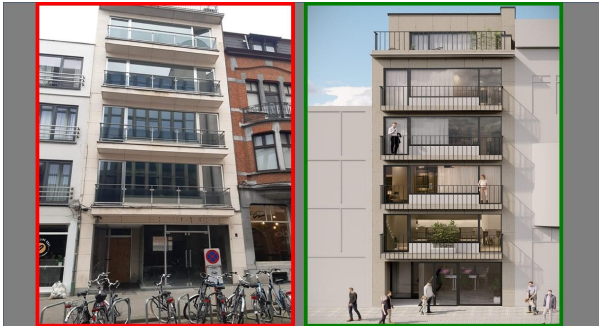
Foto: gevelrenovatie met nieuwe ramen en terrassen – links situatie vóór en rechts het project om nu goed te keuren.
